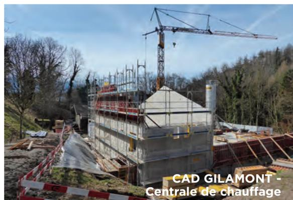
mise en place des micros-pieux, le bétonnage des fosses et une partie des murs du pourtour de la centrale, ainsi que la réalisation de tranchées drainantes.
