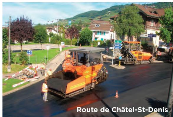
Le tronçon d'une surface totale de 3060 m<sup>2</sup> a été divisé en 9 parties, afin de pouvoir cibler les travaux. Nous avons décidé de réaliser des travaux de réfection partielle de la structure de la chaussée, afin de conserver les parties en bon état, puis de poser un revêtement bitumineux neuf sur l'ensemble.
