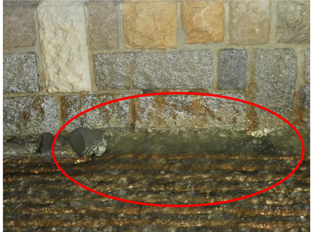
*Voûtage des Toveires : Dégât sur banquette en béton hte résistance*
