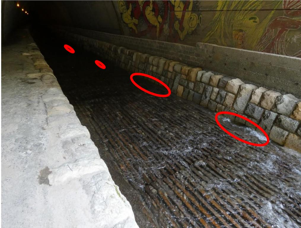
*Voûtage des Toveires : Dégâts sur banquettes en béton hte résistance*
