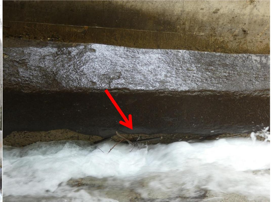
*Usure du béton et dégât sur armature apparente*
