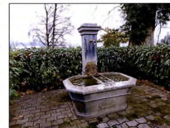
Point de contrôle sur le réseau de distribution, fontaine, Clarens
