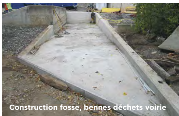
Construction rampe, accès balayeuses
